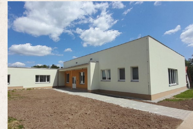
Nejvýznamnějším počinem byla realizace opravy pavilonu C v areálu mateřské školy, kde nyní sídlí školní družina pro 1. a 2. třídu základní školy.
