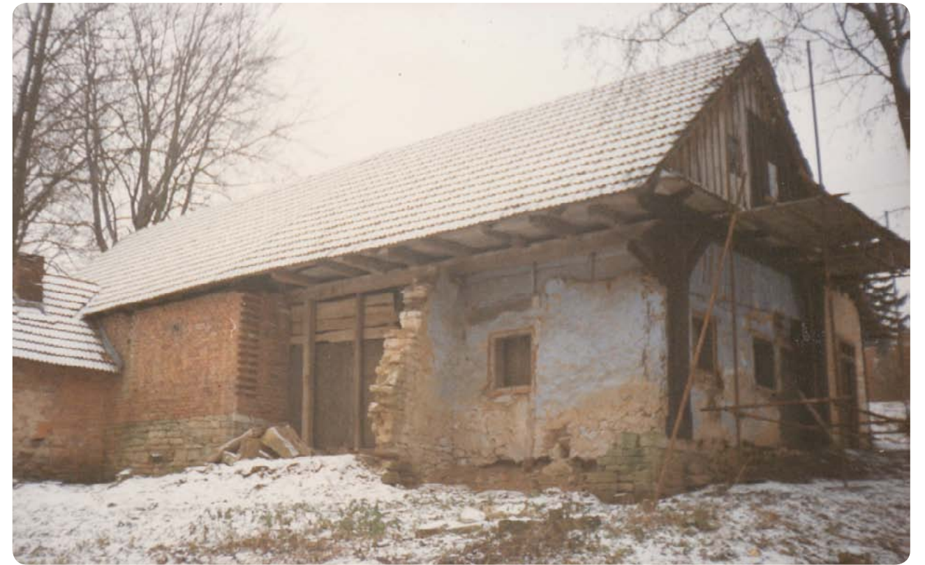
Chalupa na počátku rekonstrukce
