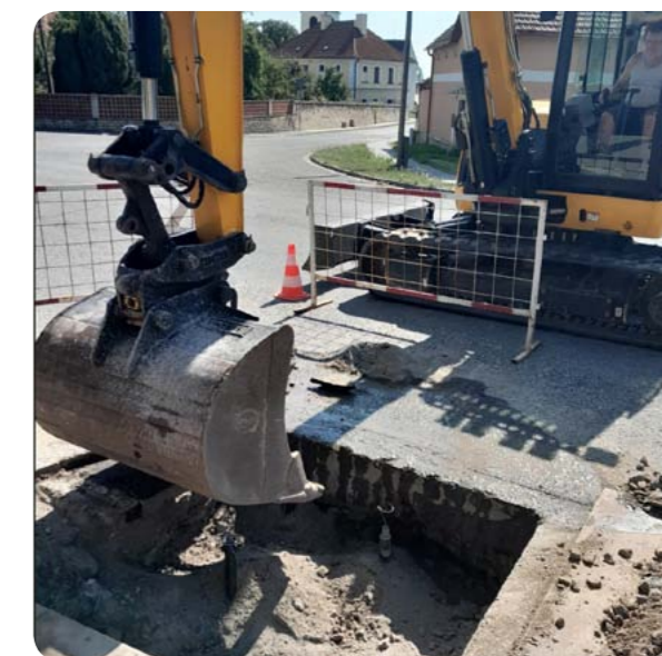
Rekonstrukce a dopravní omezení na místních komunikacích
